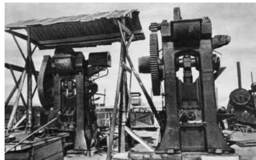
Монтаж оборудования на эвакуированном заводе. Казахстан. 1942 г.
