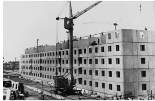
Строительство пятиэтажного жилого дома. Город Волжский
