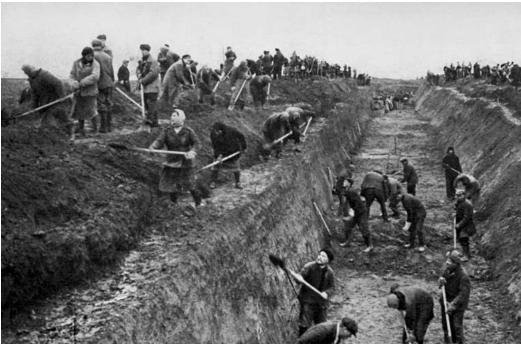
Строительство оборонительных сооружений под Москвой. Осень 1941 г.
